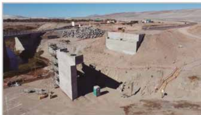
■ Vista hacia el Sur: Estribo Entrada y Cepa N°1
