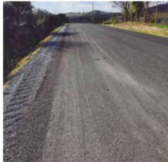
■ Desprendimiento prematuro y acumulación en los bordes de polvo de roca empleado en lechada asfáltica efectuada el año 2020
