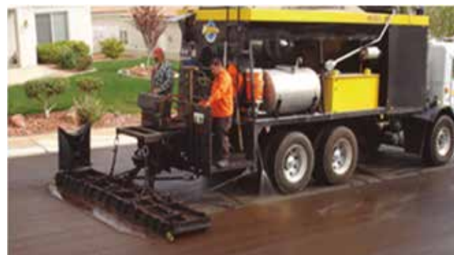
■ Aplicación mecanizada de Lechada Asfáltica
