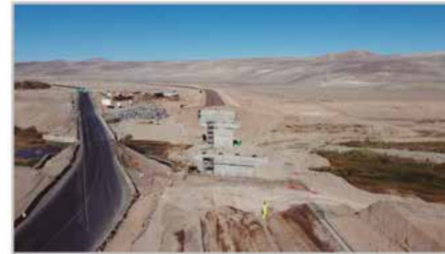
■ Vista Panorámica hacia el Sur: Estructura Puente y Acceso Sur
