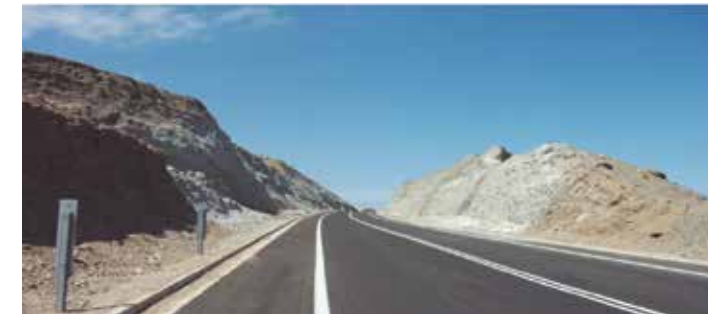
■ Conservación de carpeta de rodado de Ruta 5 Norte con lechada asfáltica
