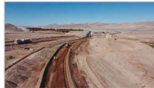
■ Vista hacia el Sur: Acceso Norte
