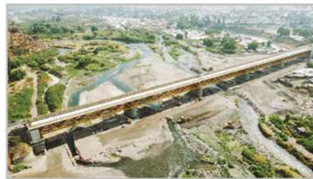
■ REGIÓN METROPOLITANA Constr. Puentes Ferroviarios Talagante, Menor Canal San Miguel y Menor Canal El Paico, Talagante
