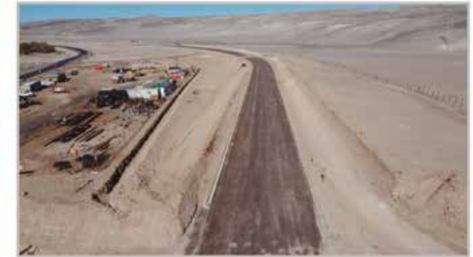
■ Vista hacia el Sur: Acceso Sur
