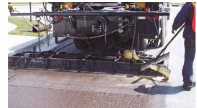
■ Pasada superficial de arpillera para lograr la rugosidad
