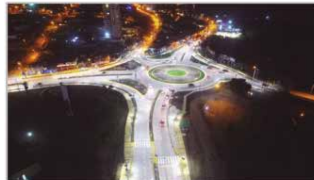
■ REGIÓN DE VALPARAÍSO Mejoramiento Ruta F-30-E Rotonda Concón
