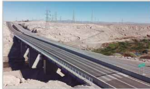
■ REGIÓN ANTOFAGASTA Construcción Puente La Posada, María Elena
