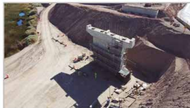
■ Vista hacia el Norte: Estribo Salida y Cepa N°2
