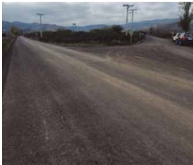
■ Desprendimiento prematuro y acumulación en los bordes de polvo de roca empleado en lechada asfáltica efectuada el año 2020
