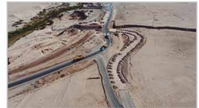
■ Panorámica Acceso Norte: Desvío de Tránsito; Acceso Norte; Obra de Arte (Cajón Doble) y Acceso Norte a Quillagua
