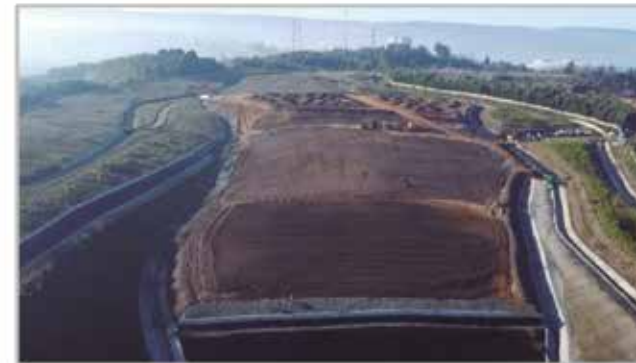
■ REGIÓN DEL BÍO BÍO Cobertura de Cierre Sector 3 - Vertedero Central Bocamina, Coronel
