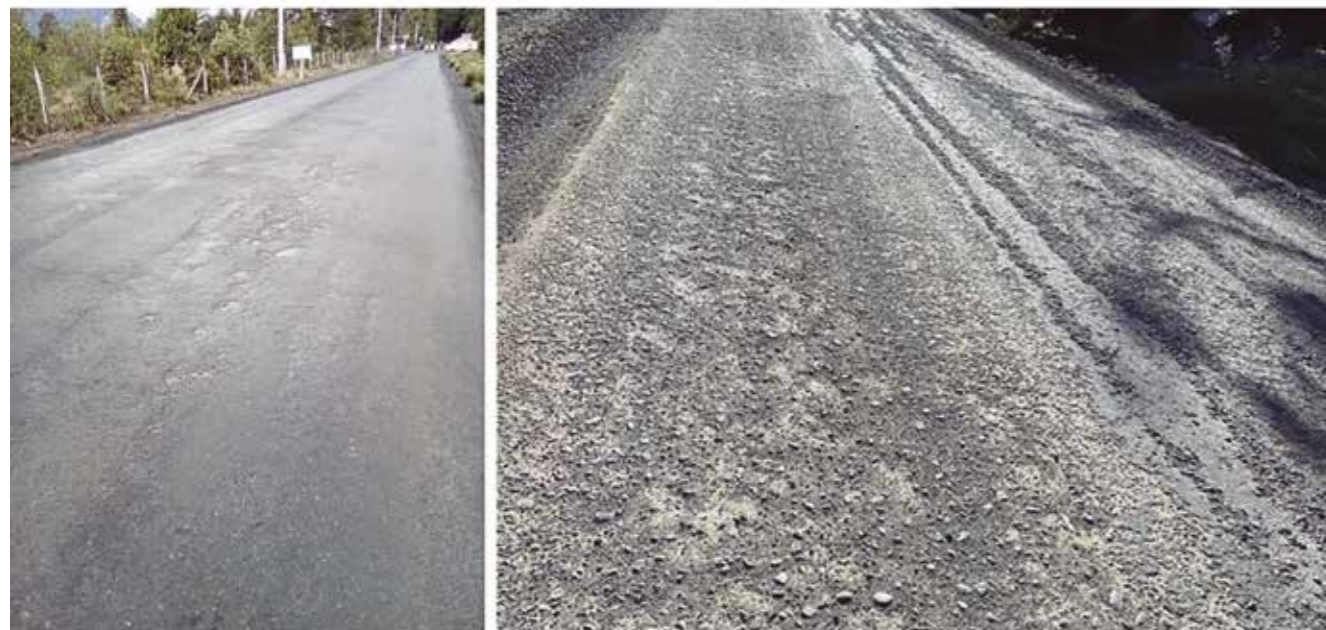
■ Ruta R-925-S Melipeuco, estado inicial con sello y después de un año de uso.
