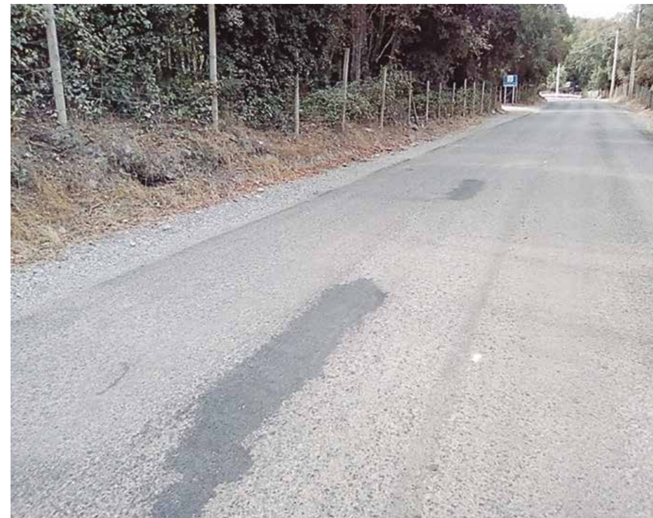
■ Ruta N-31 San Fabián. Base estabilizada con cemento sellada con Cape-Seal, contrato realizado con maquinaria especializada y terminado en marzo 2022.
