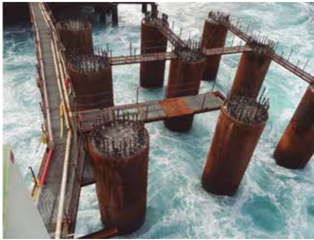
■ Camisa pilotes Puente Chacao. Fuente: elaboración propia.
