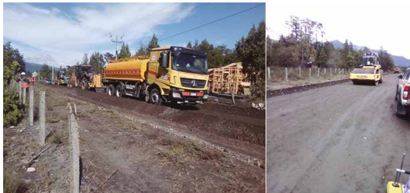
■ Ruta R-925-S Melipeuco. Construido por Administración Directa Región de La Araucanía, febrero 2022.
